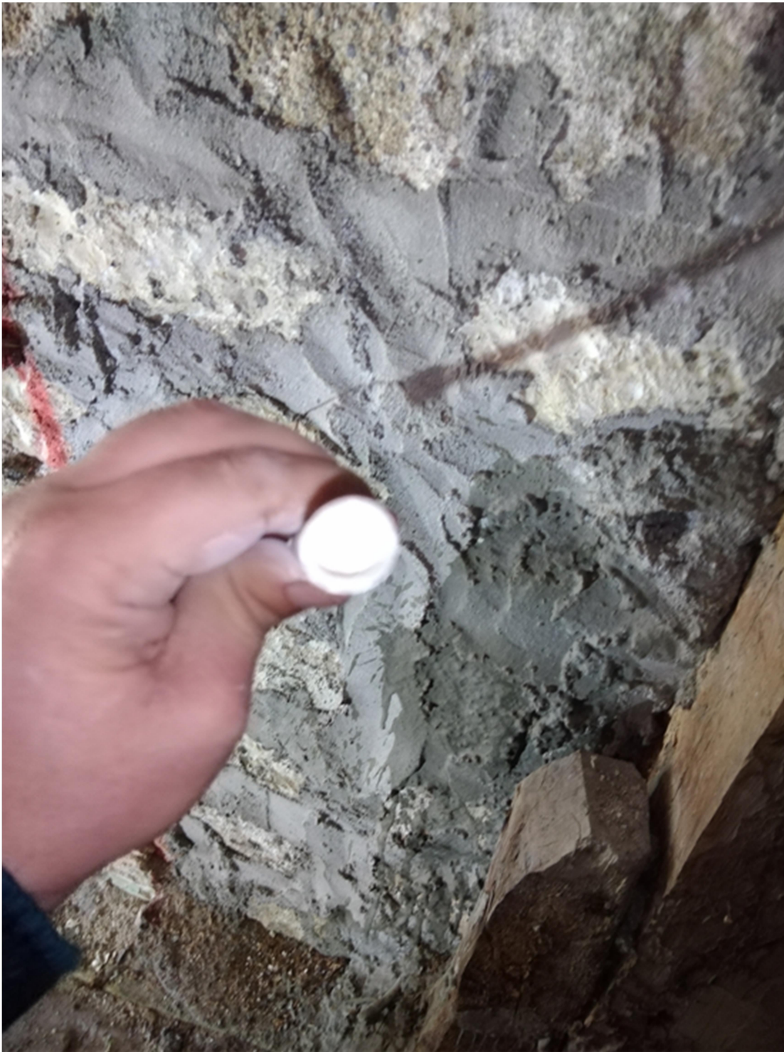
Το βουλωμένο από τις σκόνες άκρο του ακροφυσίου εισπίεσης.
